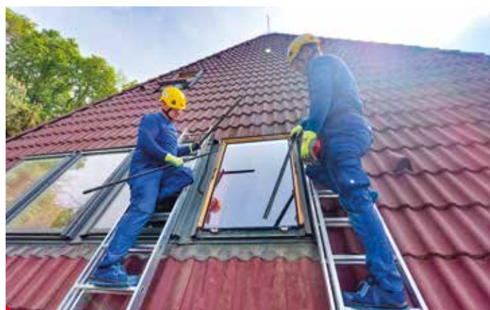
Výměna zasklení v rodinném domě v Pítkově. FOTO: AGC FLAT GLASS CZECH
